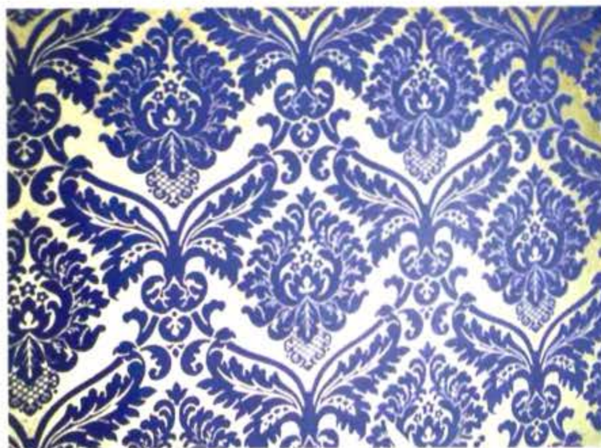
6 Wand mit Putz aus Lapislazuli mit einer Goldauflage im Brokatmuster.
